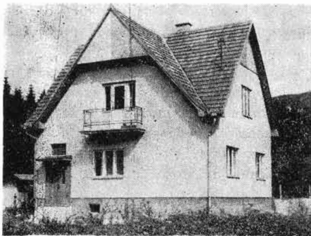
Murový obytný dom štvorcového pôdorysu z polovice 20. stor., Zákopčie, okr. Čadca. Fotoarchív NÚ SAV, Bratislava. Foto A. Pranda
